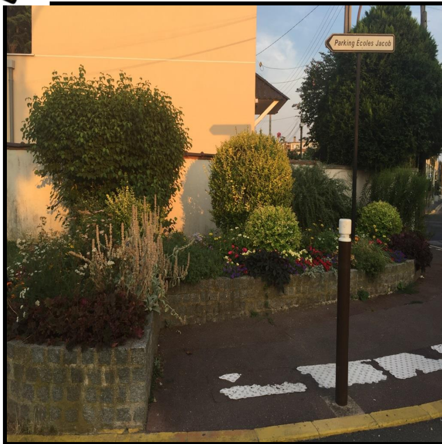
Passage piéton pk Jacob bande podotactile dégradée
